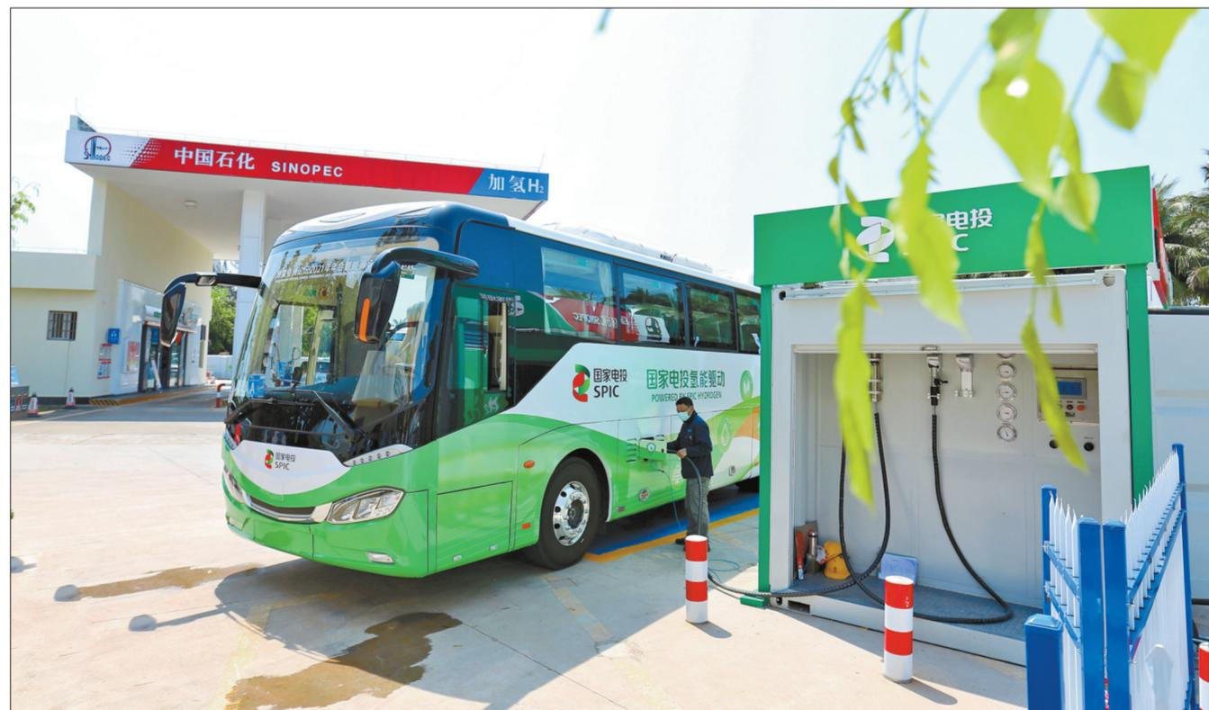
4月16日,海南省首座加氢站——海南石油琼海银丰加氢站投入运营。加氢项目采用橇装模式,配备卸氢系统、增压系统、加氢系统、氮气系统、氢气管束车停车位等配套设施,加氢能力为500千克/天。截至4月20日,共加注氢气14车次。加氢项目依托的加油站已经连续20年服务博鳌亚洲论坛,目前还提供充电服务。图为该站员工为车辆提供加氢服务。
