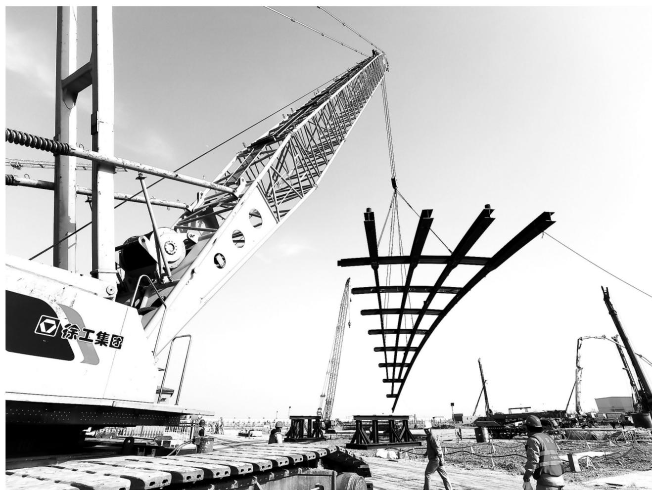
天津LNG二期项目储罐完成首片钢制穹顶骨架预制
