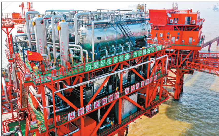
今年以来，胜利油田海洋采油厂打造“党建+”绿色发展模式，组织党员干部开展现场三标提升、隐患治理、创新创效等工作，进一步提升现场管理、安全生产水平。图为3月12日，埕岛中心二号平台党员突击队第一时间清理雨后甲板污水和积水。
