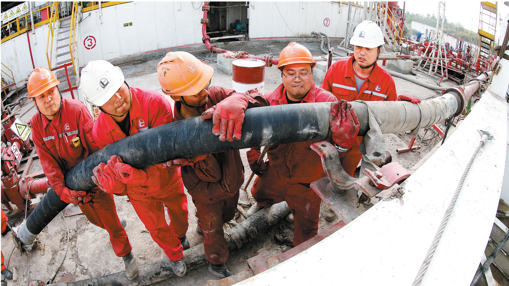
威页31平台钻井工人齐心协力连接地面管汇。
