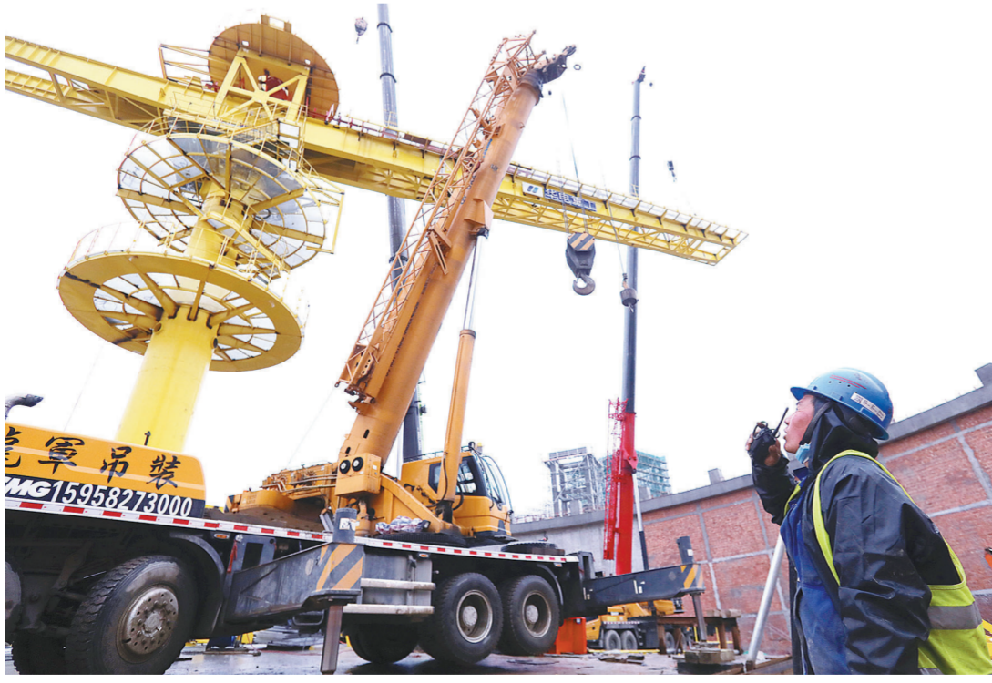
镇海基地煤焦制氢项目进入设备吊装高峰
