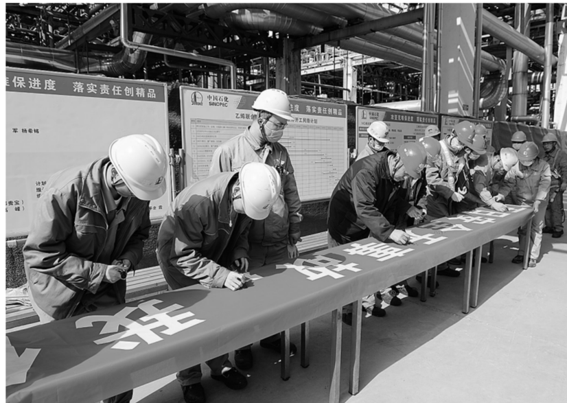
2月24日,扬子石化在1号乙装置检修消缺现场开展“百日安全无事故,我们都是践行者”安全承诺签名活动。大家在横幅上签名,纷纷表示要按照百日安全无事故专项行动要求,践行安全理念、履行安全承诺,严格遵守现场施工作业安全规章制度和安全管理规定,确保消缺工作顺利。陶炎 周宇生 摄影报道
