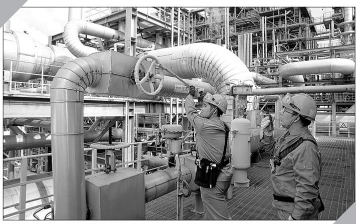
镇海炼化操作人员在乙烯装置现场进行裂解炉产汽系统调整。
