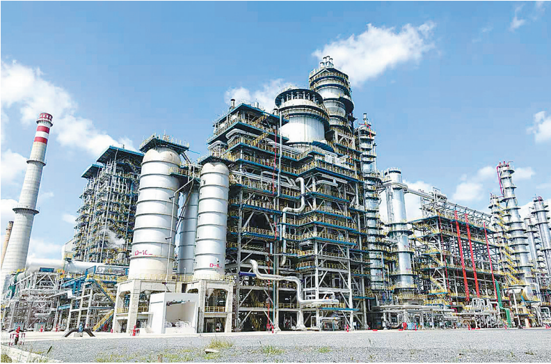
图为荆门石化新建280万吨/年重油催化裂化装置。
