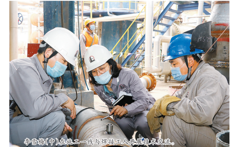
李雪梅(中)在施工现场与焊工交流。
