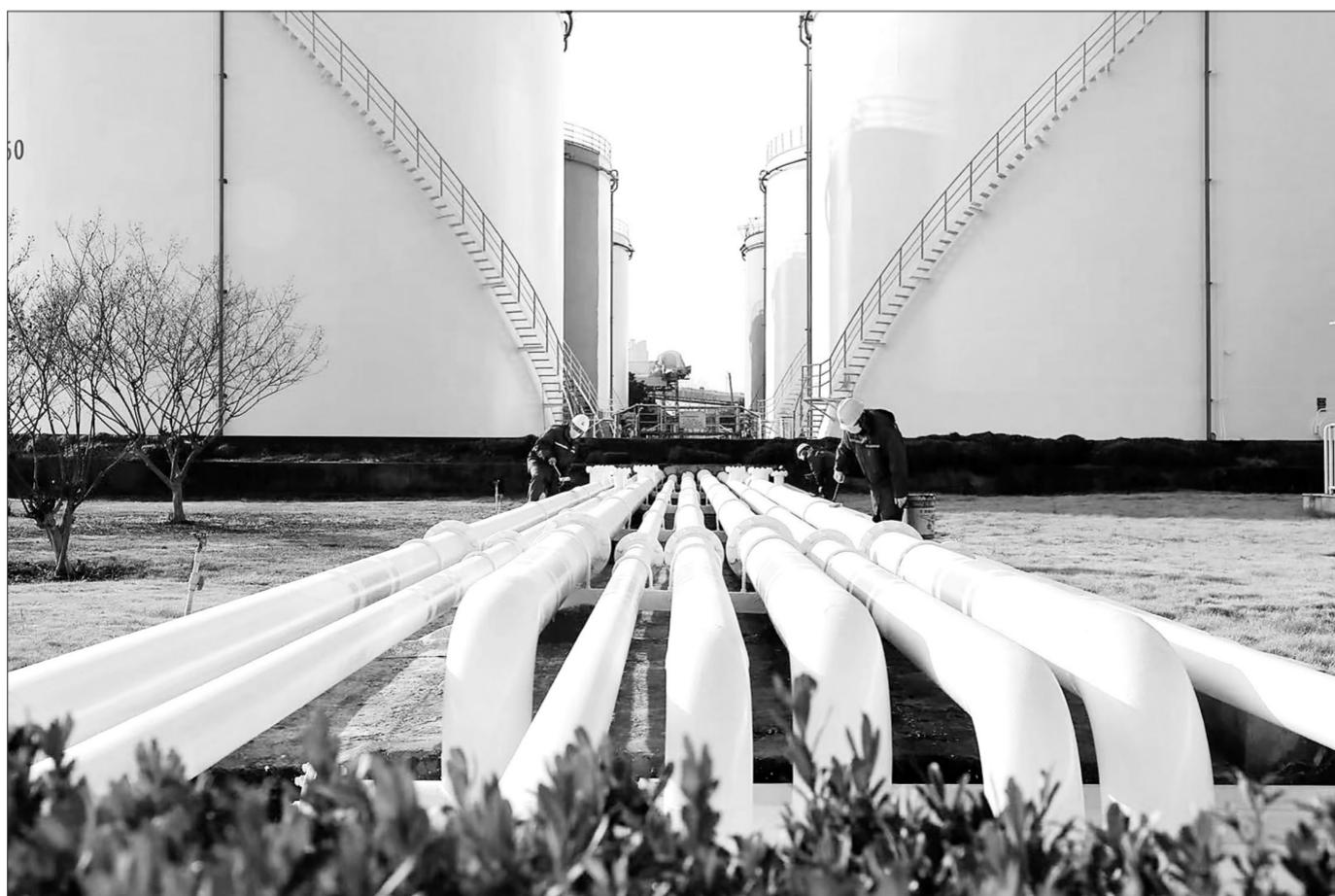
杭州石油开展工艺管道防腐施工
