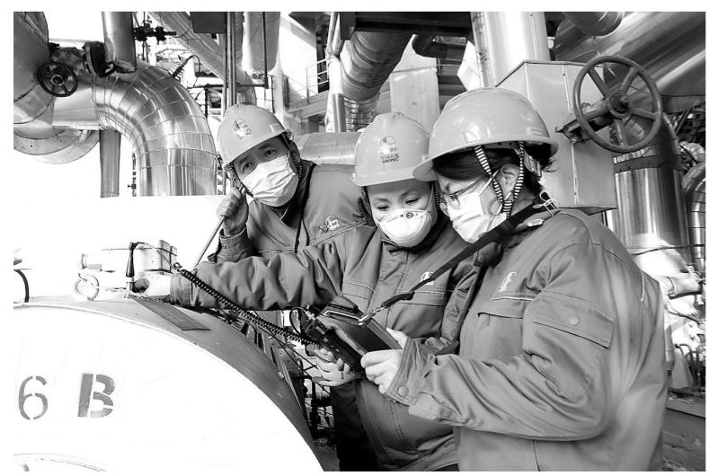
1月以来,齐鲁石化运维中心组织员工采集机泵振动、温度数据进行频谱分析,对照设备运行参数,及时消除设备故障隐患。图为1月30日,炼油机修车间员工用状态监测仪采集机泵振动数据。朱作清 摄
