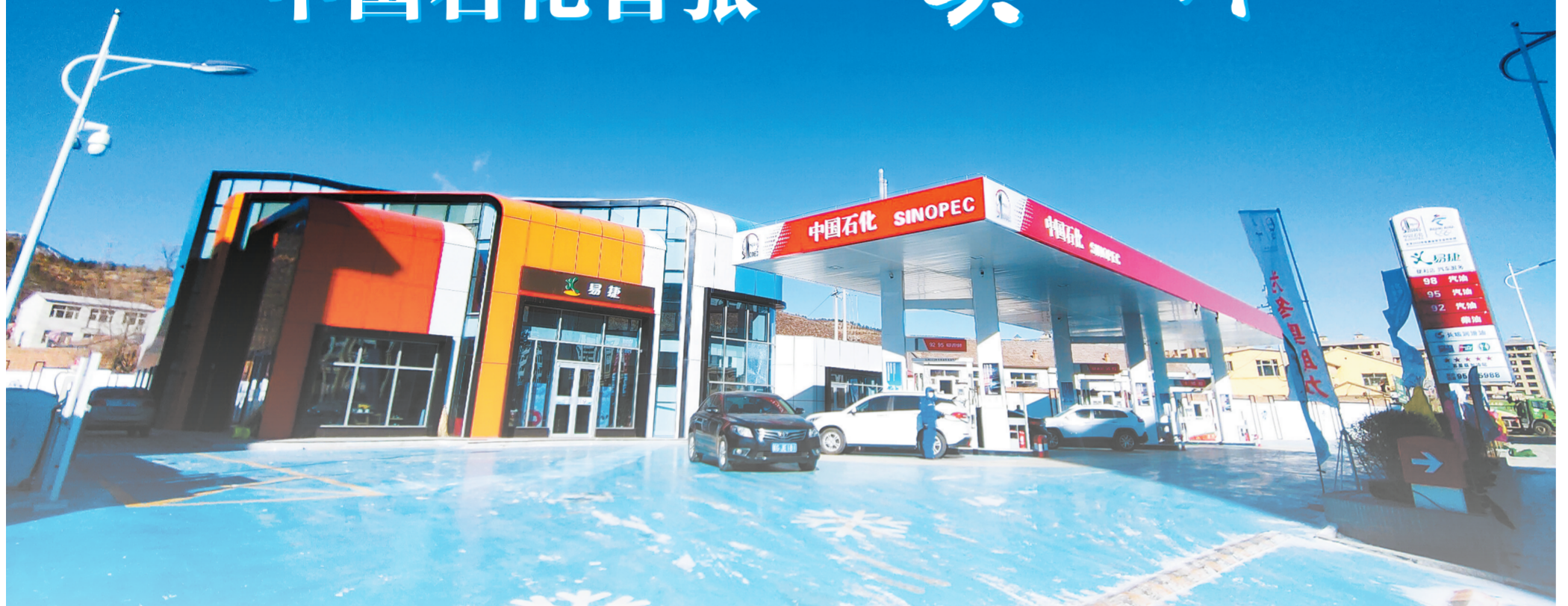
河北张家口石油崇礼第三加油站全景。
