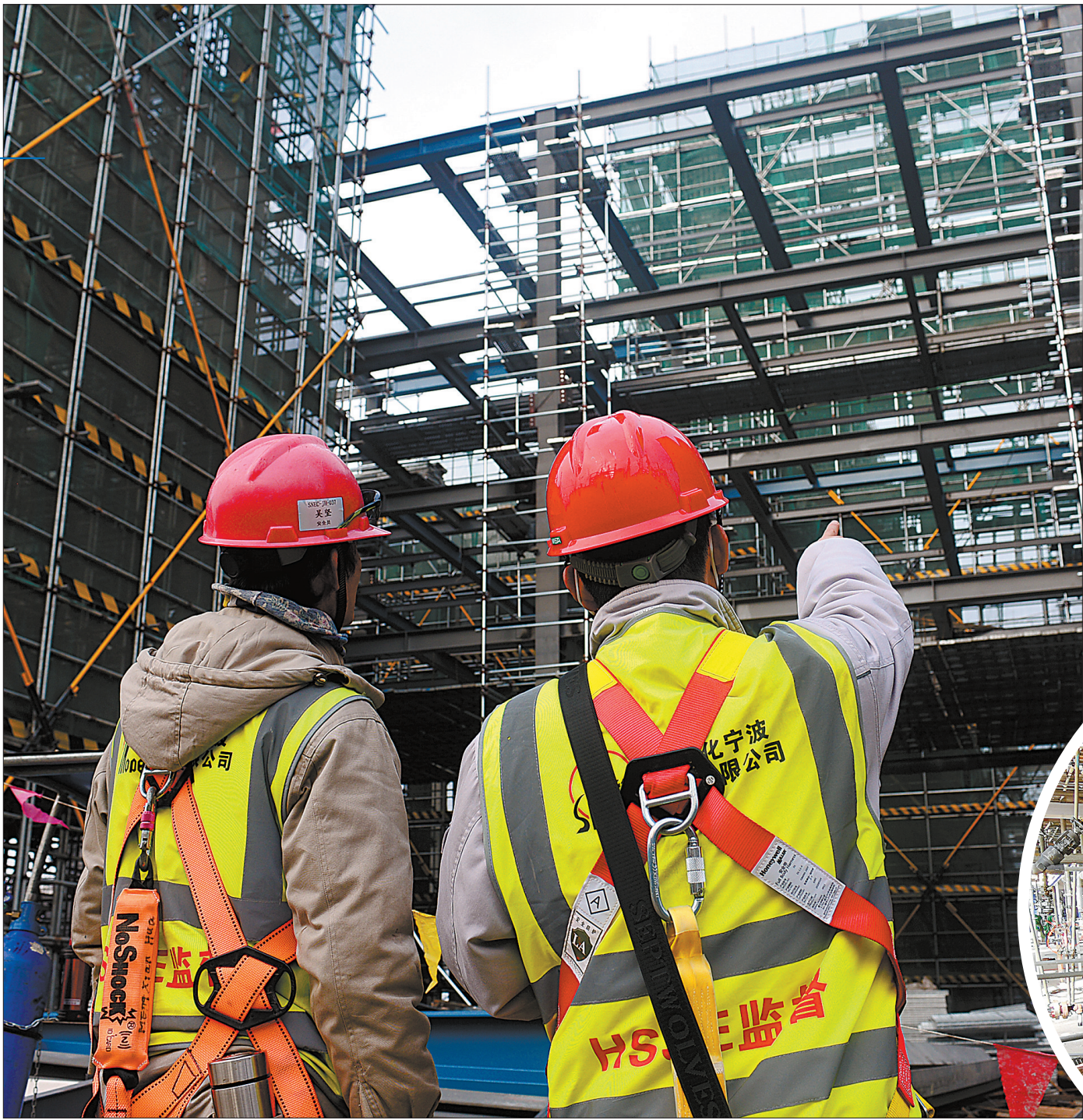
在镇海基地建设现场,宁波工程公司 HSSE 管理人员与分包商安全管理人员一起逐一查验高处临边脚手架搭设是否符合安全标准。
