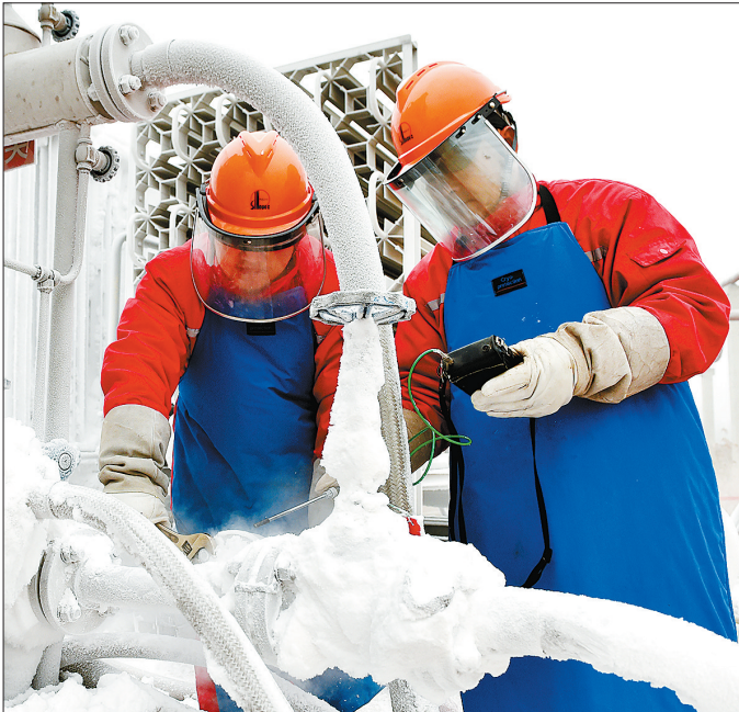
胜利油田天然气销售公司液化气项目部推行全员安全诊断活动,对各运行站点LNG气化装置进行全面测试,消除隐患。图为1月22日,液化气项目部安全人员对气化装置密封点进行测漏检测。
