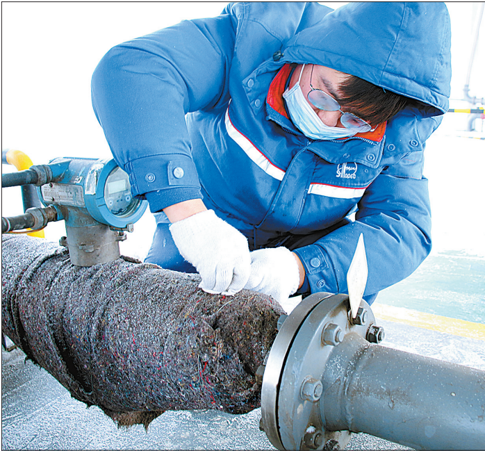
近日,新疆北部普降大雪,气温骤降。乌鲁木齐石油库组织员工全面检查设备保暖状况,确保生产正常运行。图为1月26日,员工为付油台流量计增加保温层。
