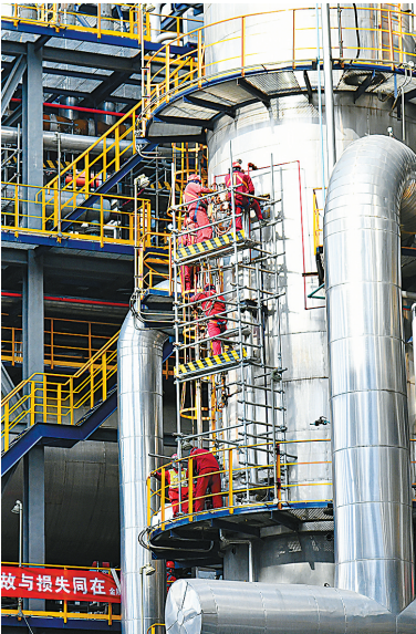
图为施工人员进行重油分馏塔液位计更换作业。
