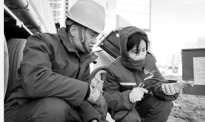
淮南石油强化加油站接卸环节安全管理,实施油品接卸作业时,严格执行“卸油八步法”操作流程,做到先接地后卸油。过程中员工与司机全程现场监护,确保油品接卸安全。图为1月16日,田大路加油站计量员刘明月在接卸油品前检查静电接地设备,并进行防静电设备的日常安全维护保养工作。宋晖 摄
