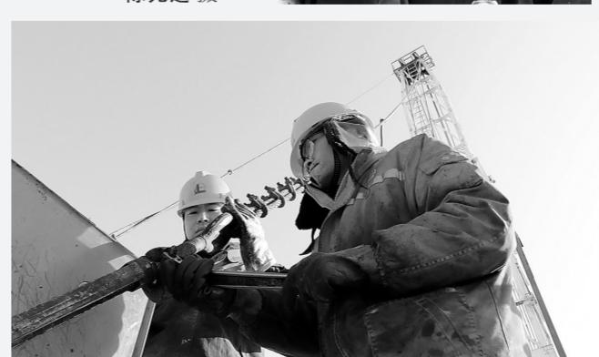
胜利油田油气井下作业中心东辛作业区开展“我为安全作诊断”隐患排查活动,并加大安全诊断的奖惩力度,调动各岗位员工查隐患保安全的积极性。图为1月18日,作业区班组员工在检查紧固井架绷绳。
