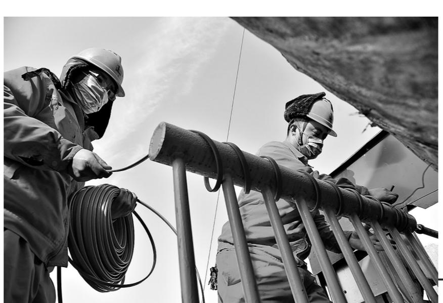
◀极寒天气给油井升温降压带来不利影响。胜利油田东辛采油厂推广实施“伴生气分离+低氮燃烧”的冬季组合升温管理模式,提升油井管输温度,实现不冻堵一口油井、一条管线、一台设备的目标。图为1月20日,员工为油井伴生气分离装置加装伴热带。
