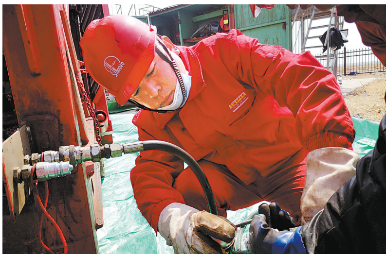
2020年12月29日,东北油气田北213-21HF井,田明在检查连续油管设备状况。
