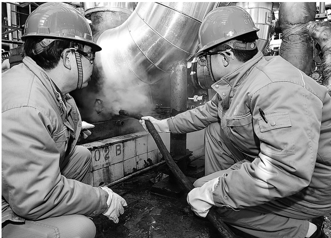
上海石化化工部在各生产装置划分责任区,指定管理人员分管区域内防冻保暖工作,加大对变送器、导压管、疏水器等设备设施的检查力度。图为1月11日,员工在为设备加热解冻。 高卫洪 摄
