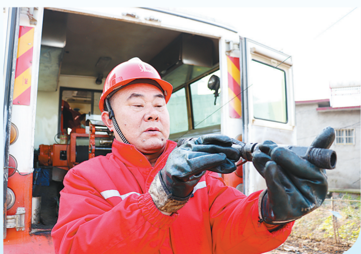
朱一斌在施工现场检查仪器扶正器。
